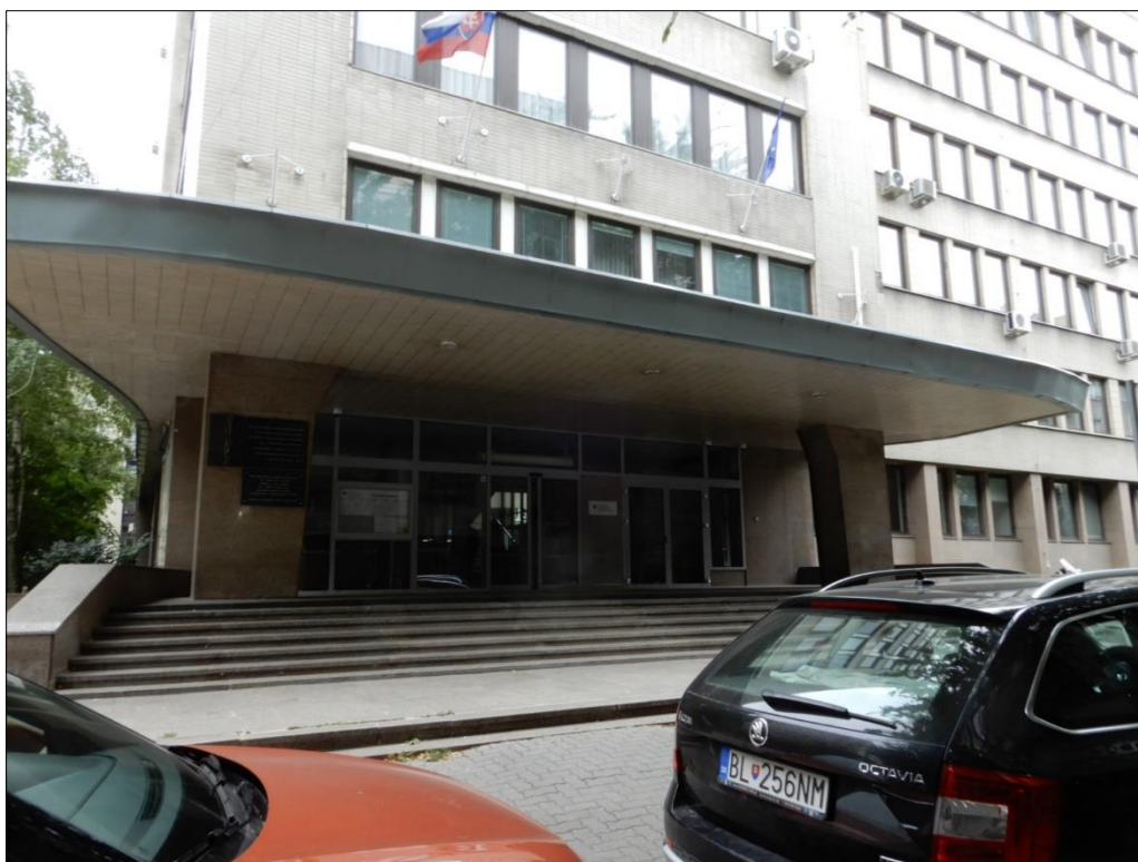
Hlavný vstup, Dobrovičova ul. č. 12
