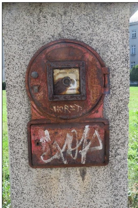
Dvierka s hlásičom a telefónom.
