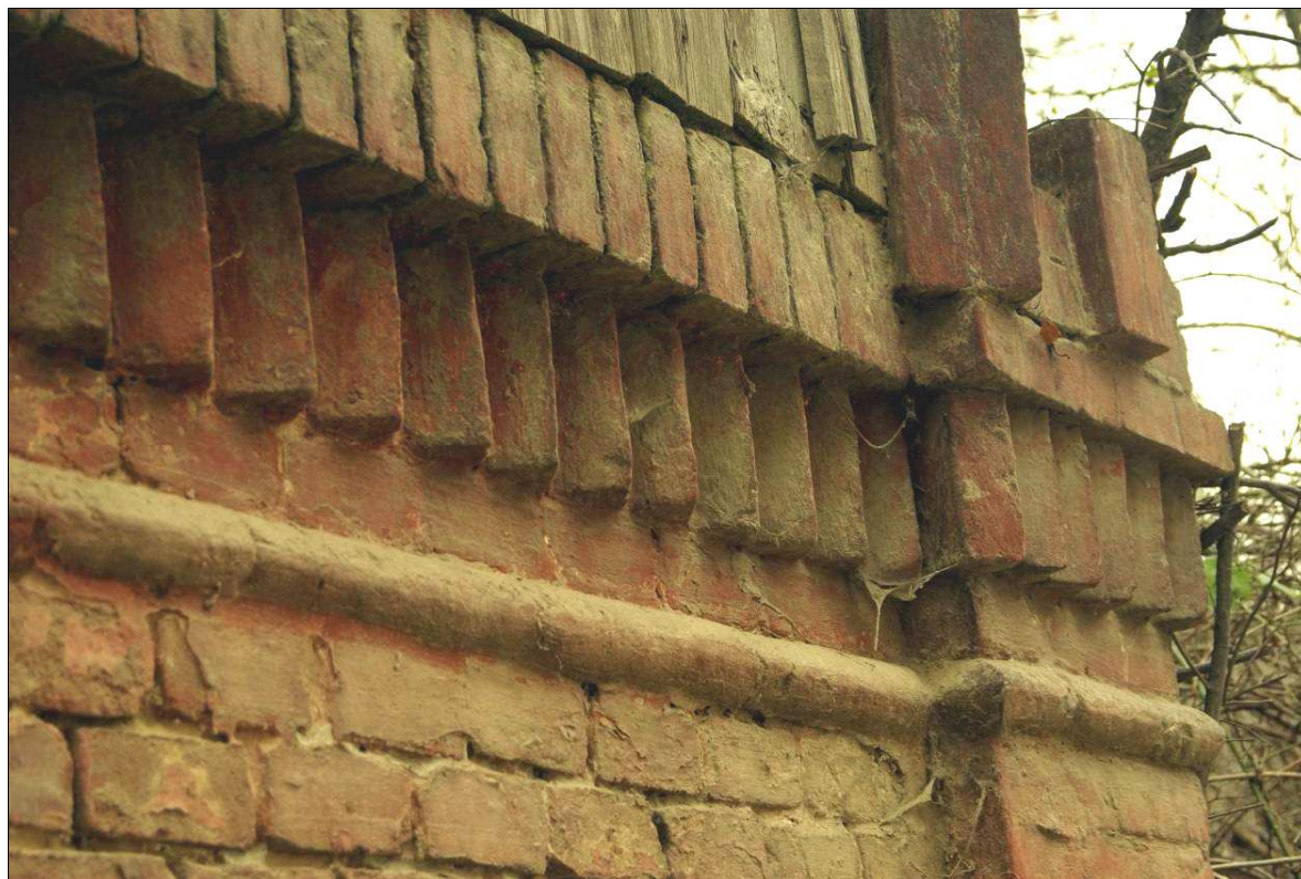
Detail tehlového muriva pivnice
